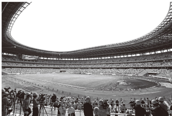
報道陣に公開された新国立競技場の建設現場。東京都新宿区で2019年7月
