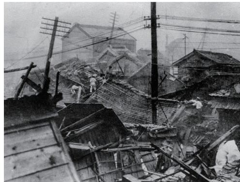
当時は建物の「耐震基準」がなく、多くの家屋が倒壊しました
